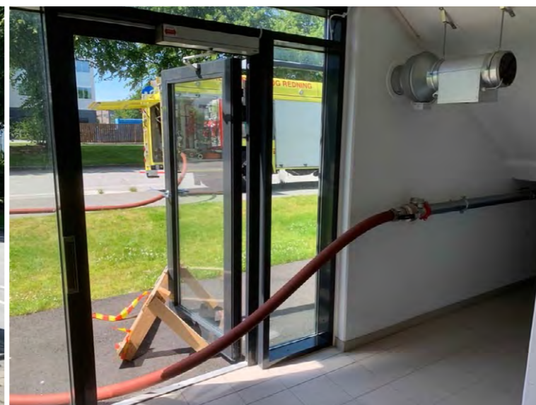
Bildene viser hvordan brannmannskapene benytter seg av stigeledningen i parkeringshuset. Foto: Erik Berge, RBR.
