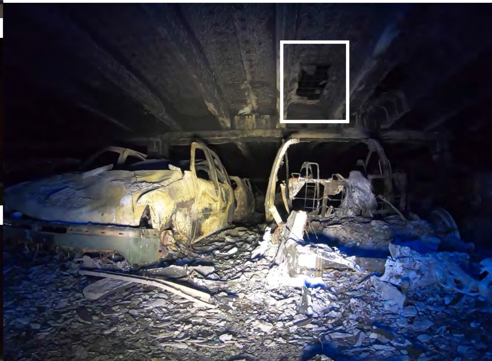
Avskalling av spennbetongelementer i parkeringshuset, med åpning gjennom dekket. Foto: Politiet.
