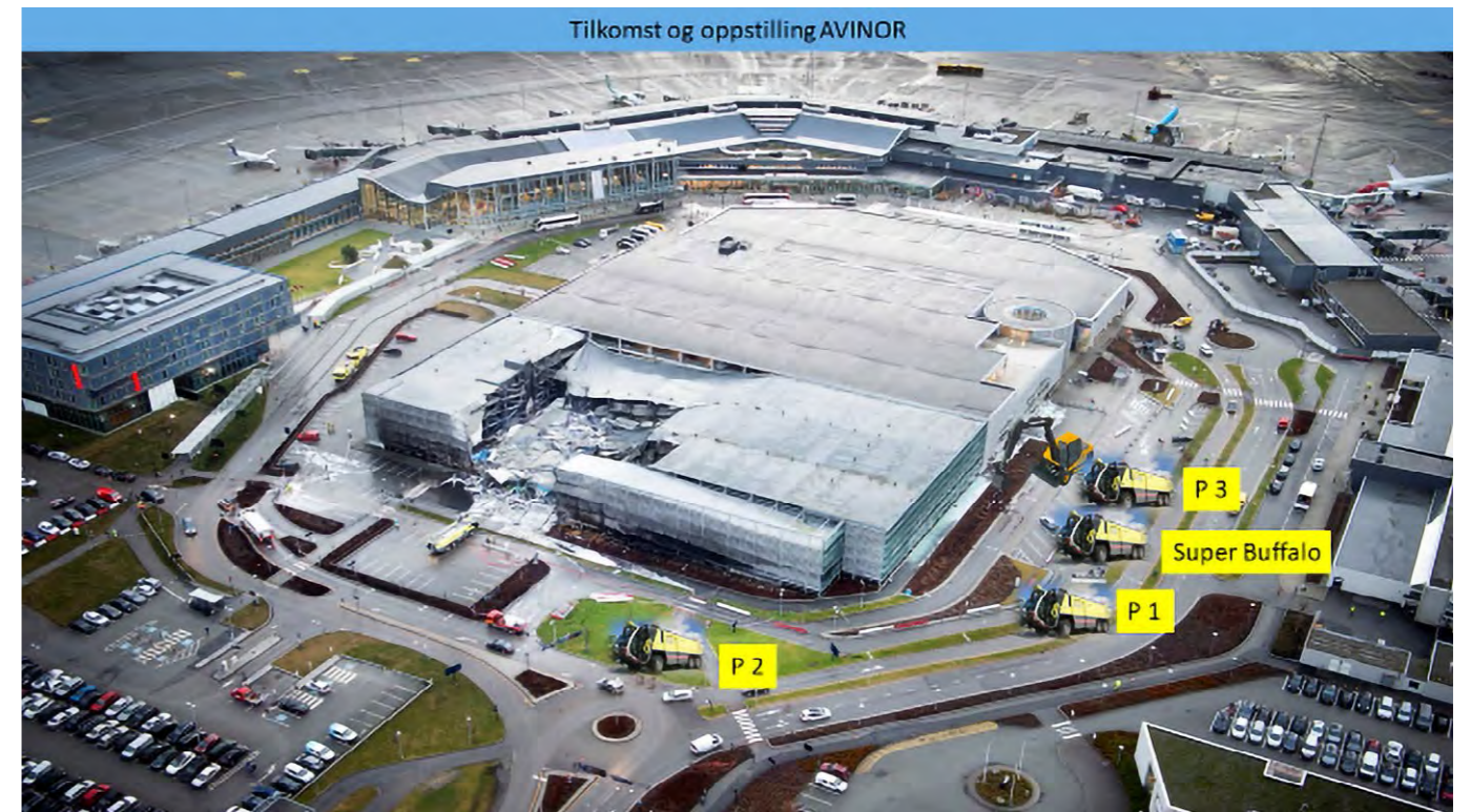
Bildet illustrerer hvordan innsatsen var på sørvest siden etter at den innvendige innsatsen ble avsluttet og byggetrinn 3 kollapset. Gravemaskin ble rekvirert for å rive fasadeplater/lameller. Foto: Fredrik Refvem, Stavanger Aftenblad.
