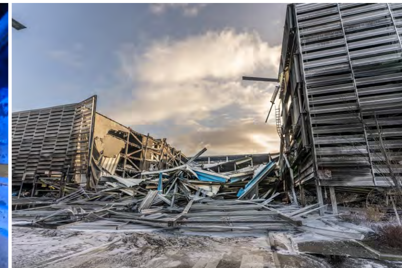
Skille mellom byggetrinn 2 og 3. Foto: Frode Ueland, RBR.
