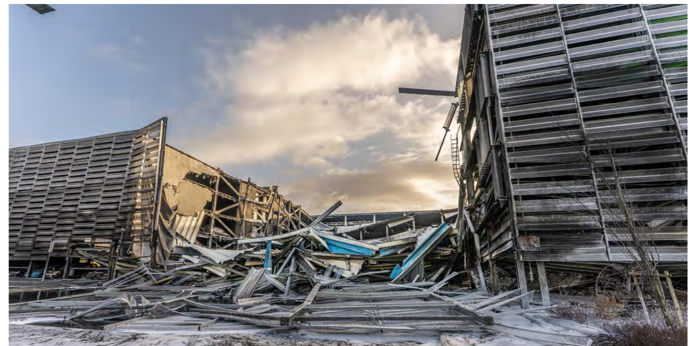
Byggetrinn 3 kollapser cirka 1 time og 57 minutter etter at brannen startet i byggetrinn 2. Foto: Frode Ueland, RBR.
