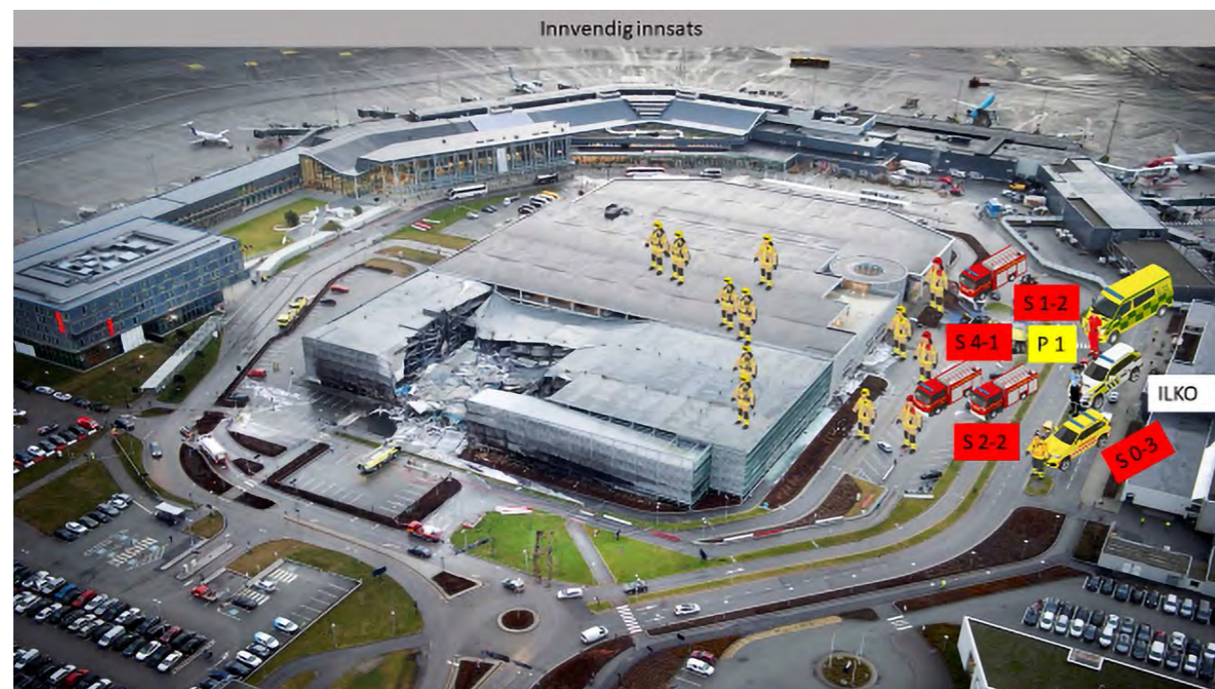
Bildet illustrerer den første innvendige innsatsen i parkeringshuset. Foto: Fredrik Refvem, Stavanger Aftenblad.
