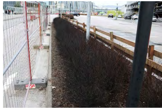
Det ble opprettet 25 meters sikkerhetsavstand rundt parkeringshuset. Bilde er tatt 09.01.2020. Foto: Kenneth Vik, RBR.
