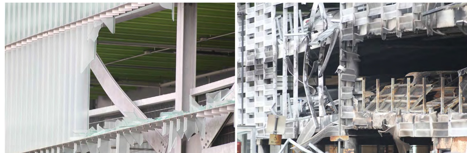
Fasadeplater byggetrinn 3 og 2. Foto: Lasse Grahl-Jacobsen, RBR
